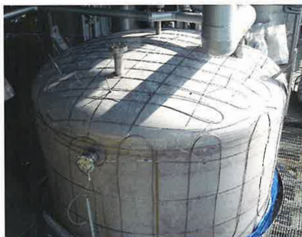
MIヒータ施工例
